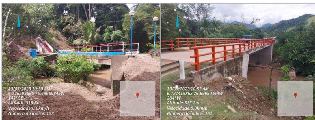
FIGURA N° 02: CON EL AUMENTO DE LA QUEBRADA EN EPOCAS DE AVENIDAS, GENERA EROSION EN LOS BORDES CERCANOS A INFRAESTRUCTURAS VIALES Y PEATONALES PROPENSOS AL COLAPSO DEJANDO INCOMUNICADO AL SECTOR DEL BARRIO SAN JOSE - AGUA BLANCA.
